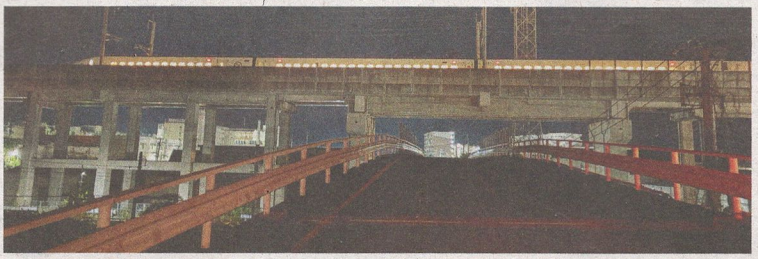
避難訓練で、高架上に退避する新幹線の車両(13日、熊本市で)＝JR九州提供
