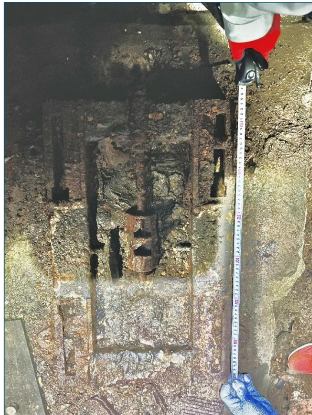
写真 20：台座の上面に残っていた機械痕（2023年8月27日筆者撮影 ※明るさ調整済み）
