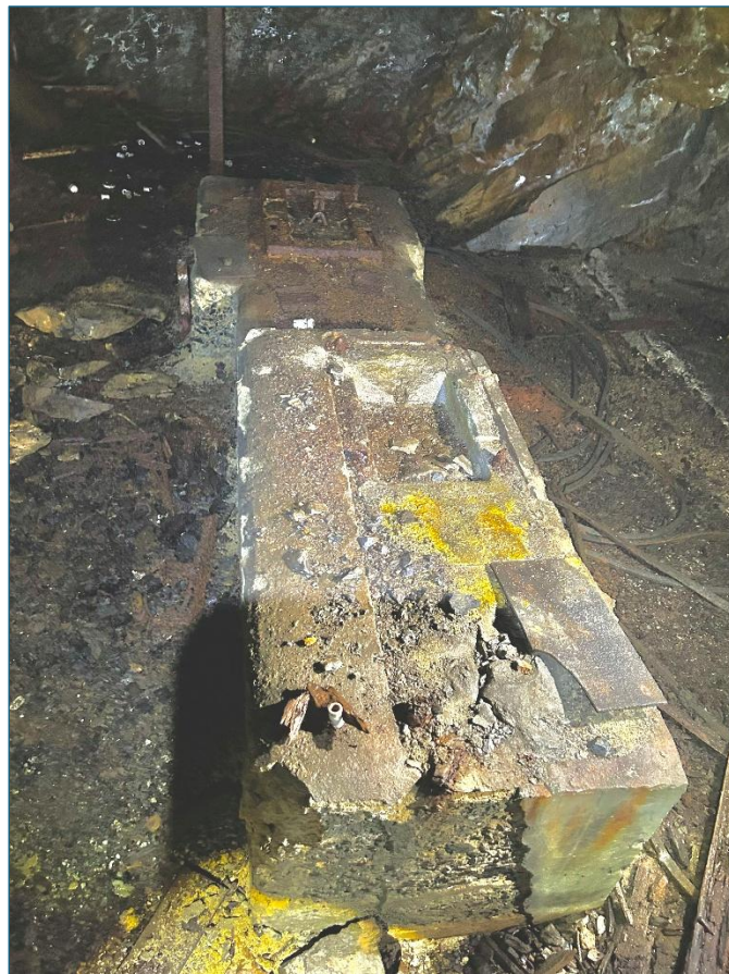
写真 19 : 手前から見たコンクリート製の台座 (2023 年 8 月 27 日筆者撮影 ※明るさ調整済み)
