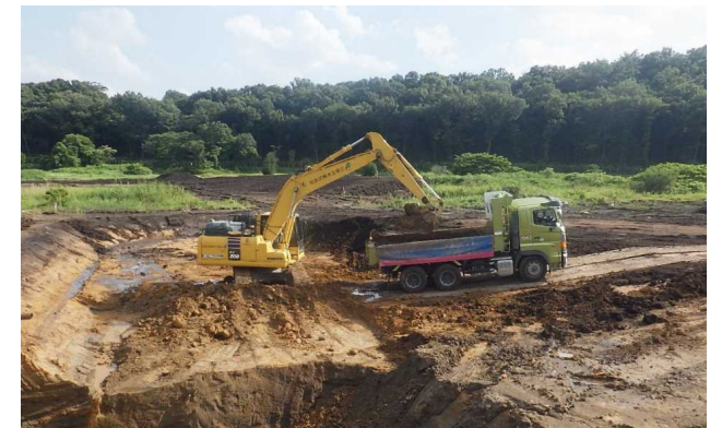
敷地造成工事(イメージ)
