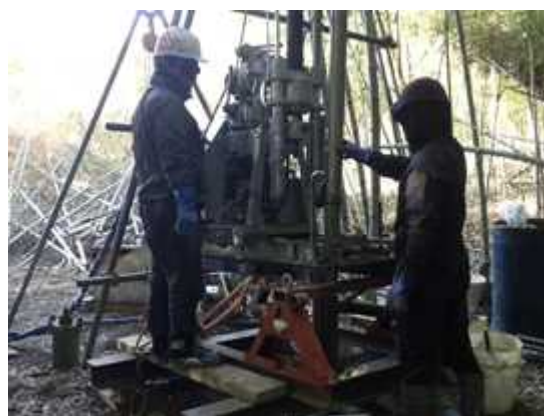
ボーリングによる試料採取
