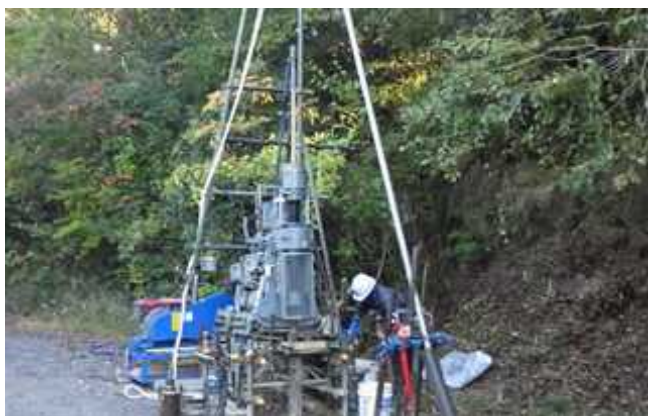
ボーリング調査
