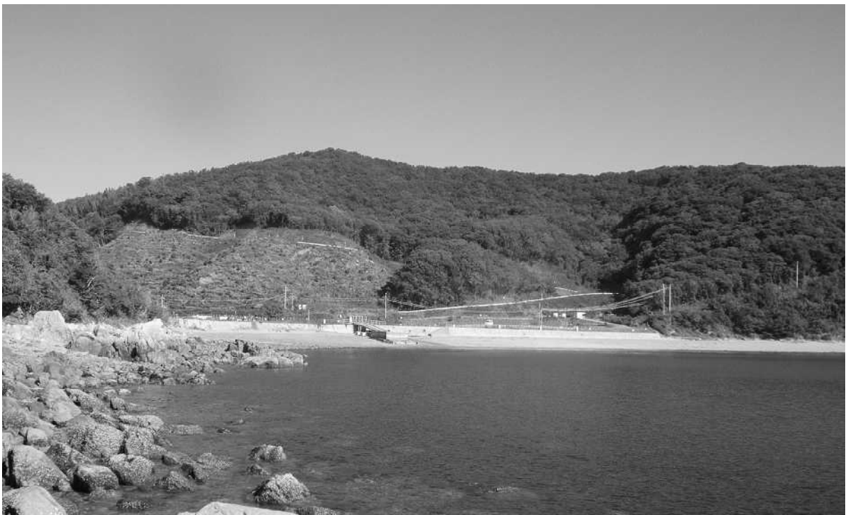
上関原子力発電所建設予定地の最近の状況. すでに相当の山林が伐採されている. 2009年9月20日, 佐藤正典撮影.
