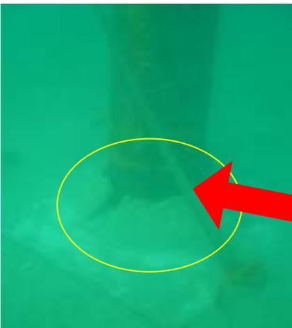
コンクリートとガイドパイプの間を埋めるが、掘削面が露出。易なパテが無残にはがれ、掘削面が露出。
