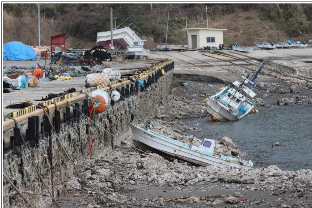
能登半島地震で地盤が隆起し、海底が露出した鹿磯港 = 12日、石川県輪島市
