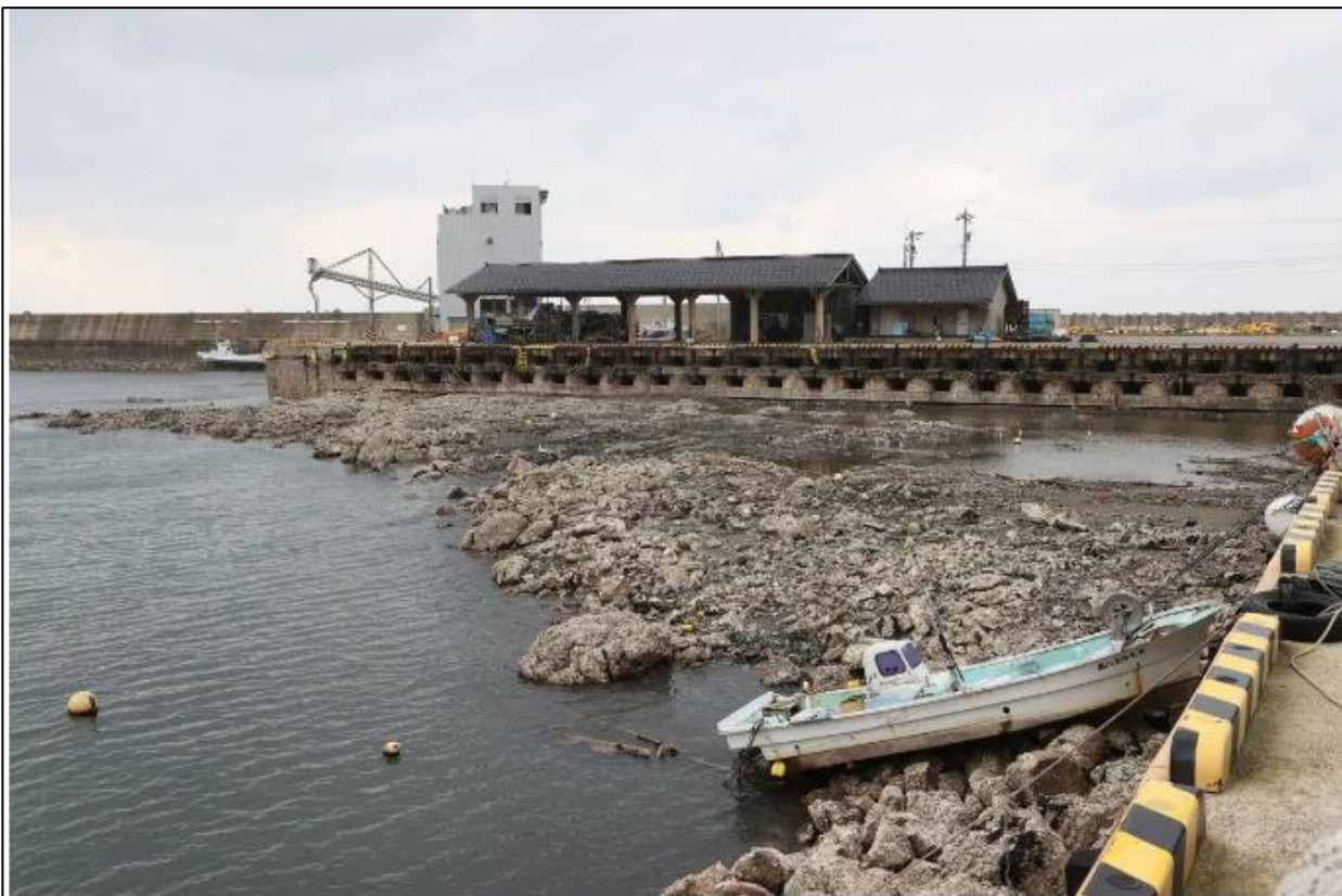
能登半島地震で地盤が隆起し、海底が露出した鹿磯港 = 12日、石川県輪島市
