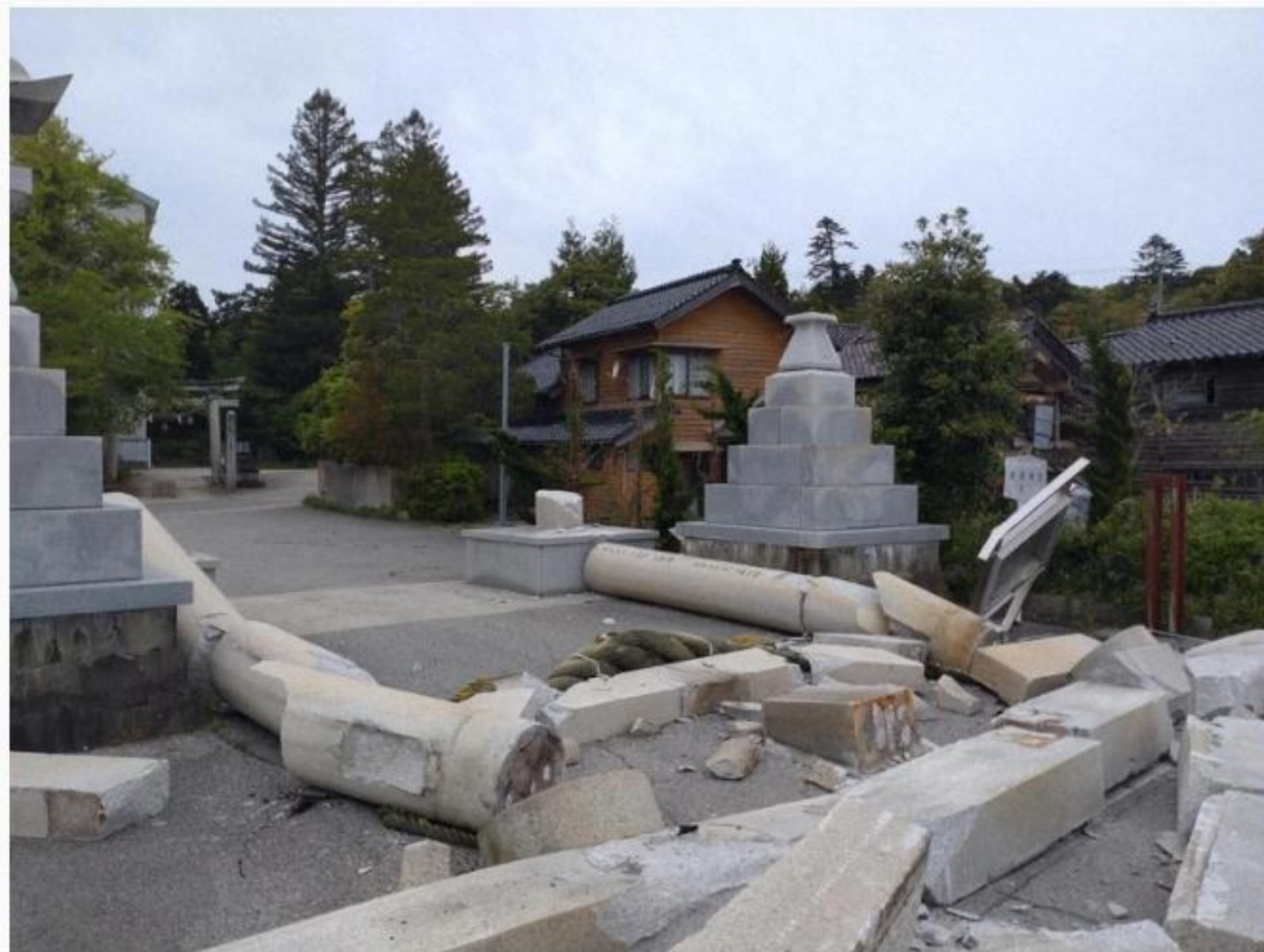
最大震度6強の揺れを観測した地震で、倒壊した須須神社の鳥居 = 石川県珠洲市三崎町で2023年5月5日午後3時半ごろ、深尾昭寛撮影
