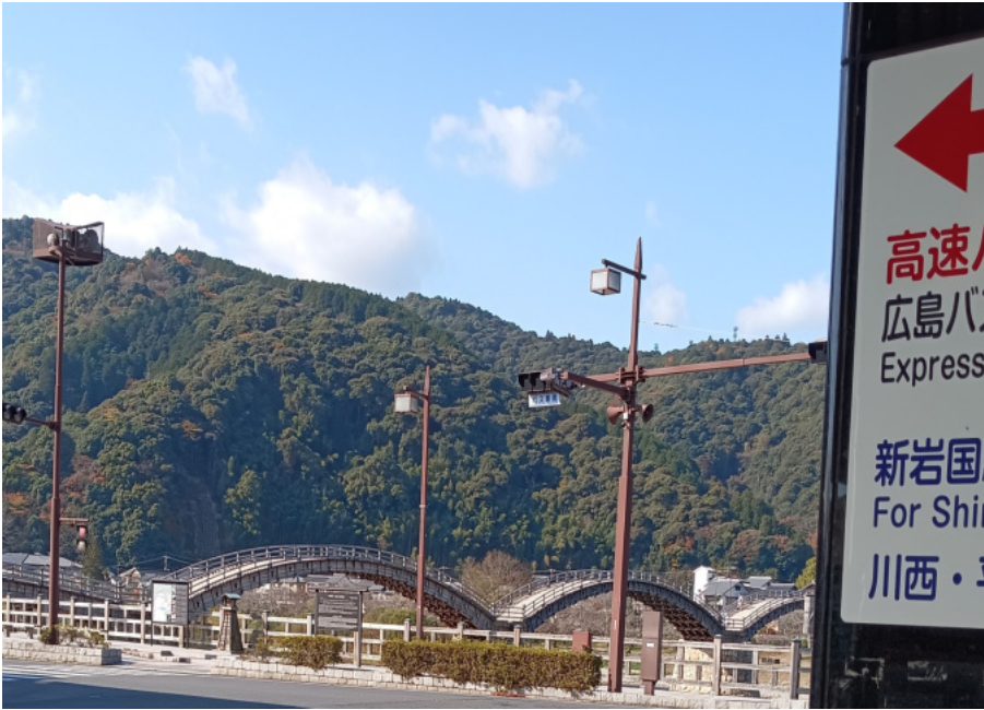
岩国市の錦帯橋
