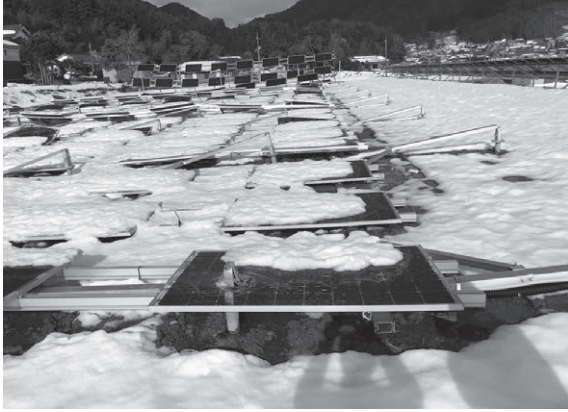
図1：雪で倒壊したソーラーパネル（2021年1月）
