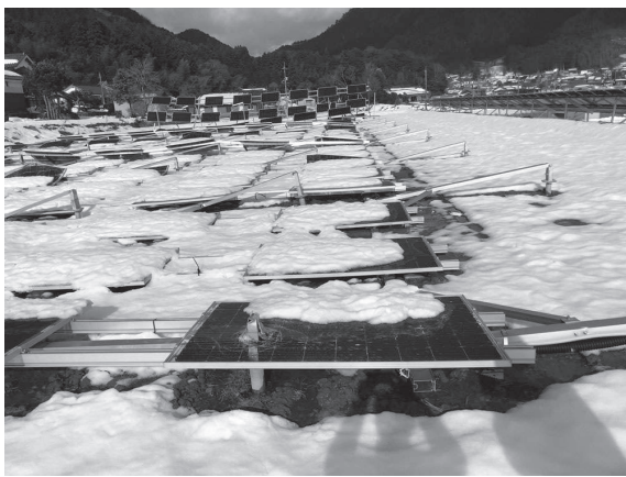
図1：雪で倒壊したソーラーパネル（2021年1月）
