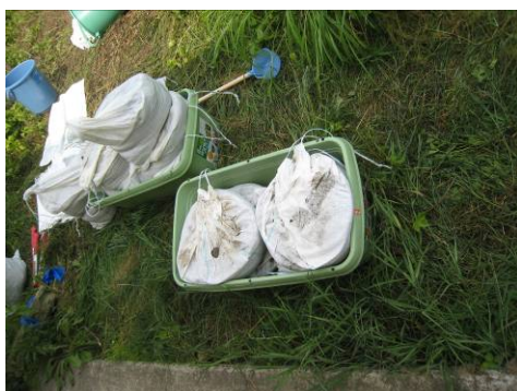
写真20 固めた液を投入した土のうをプランターに入れ、直方体の形に整える
