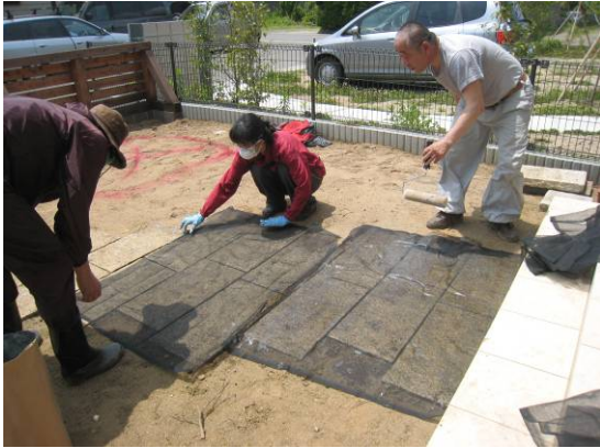
写真 29 敷石の間の雑草、コケ、汚染土壌を取り除いてから、敷石表面に寒冷紗+PVAを実施する。
