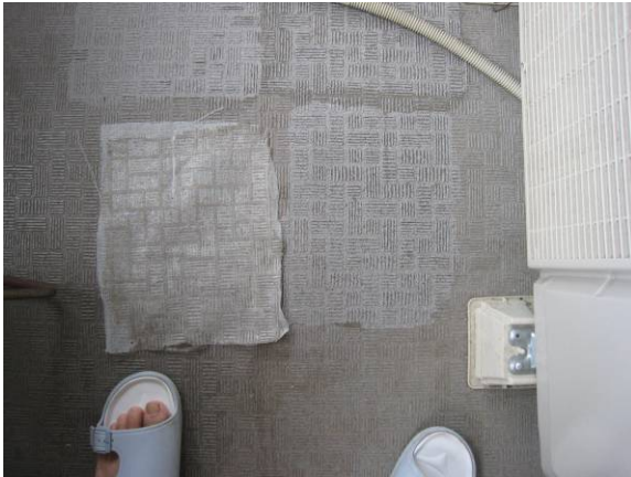
写真17 寒冷紗+PVAによって、汚れが剥がされた跡
