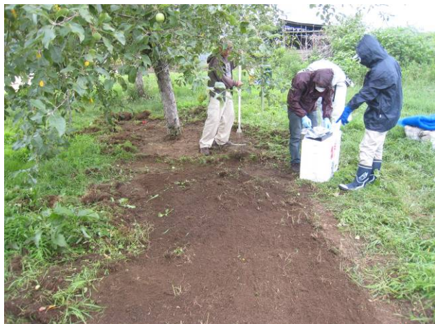
写真23 青リンゴの果樹園における除染の様子。木の根っこが思わぬところにあり、注意しながら土を除去して、デンプンを混ぜて土のうに入れ、形を直方体に整える。
