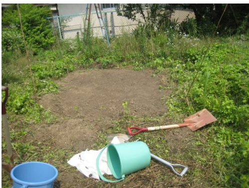
写真37 穴を掘ったときの出てきた、汚染されていない 土壌で表面を埋め戻し、放射線量測定を行い、 1 \mu\text{Sv/h} (できれば 0.5 程度)より低いことを確認して完了。
