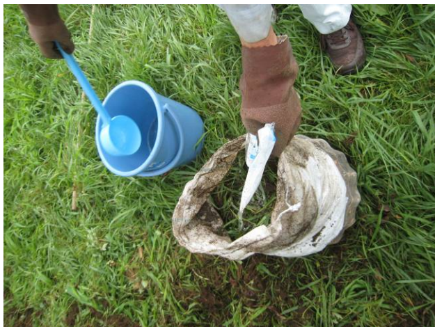
写真 3 4 雑草と土を除去し土のうに入れてPVA液を入れて固める
