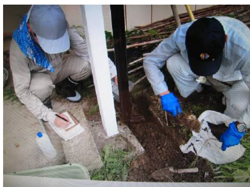
写真21 雨樋下のホットスポットをPVA液で緩めては、ちいさなスコップで土をすくい取り、土のうに入れている様子。
