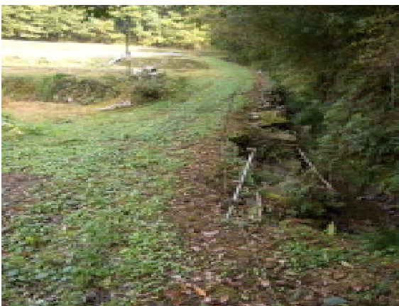
谷川も道も壊れたまま、イノシシ対策も必要。稲作を続けることで先祖伝来の村里がどうにか守られている
