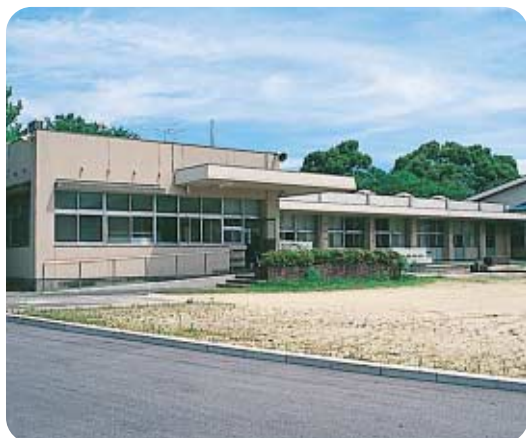
地域共生センター外観
